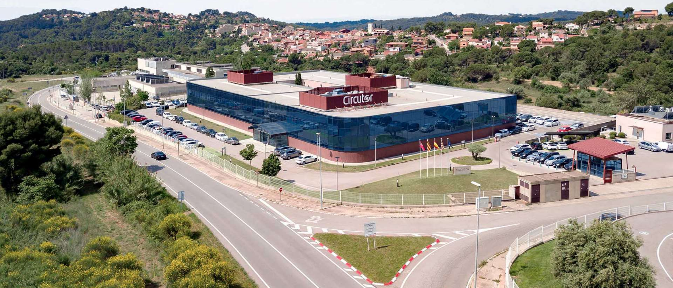
▮ Sede central CIRCUTOR en Viladecavalls (Barcelona)
